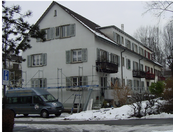
Strassenfassade vor Sanierung/ Aufstockung
