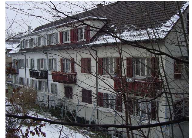
Strassenfassade vor Sanierung/ Aufstockung
