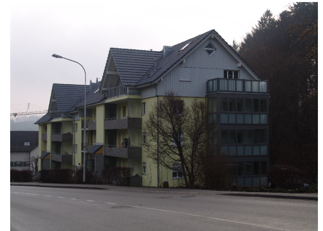
Strassenfassade nach Umbau/ Aufstockung
