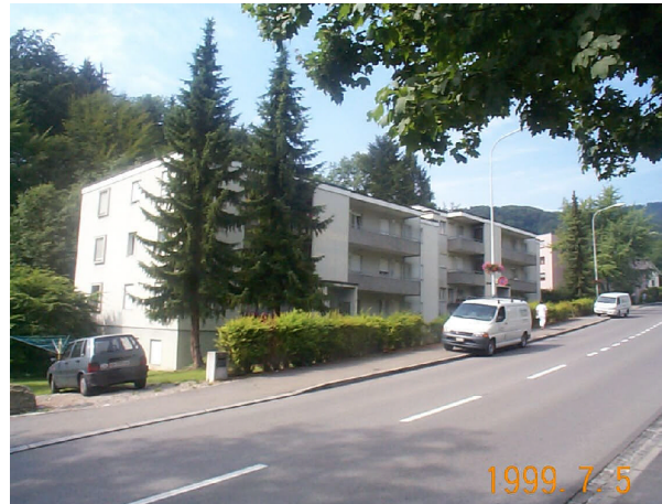
Strassenfassade vor Umbau/ Aufstockung
