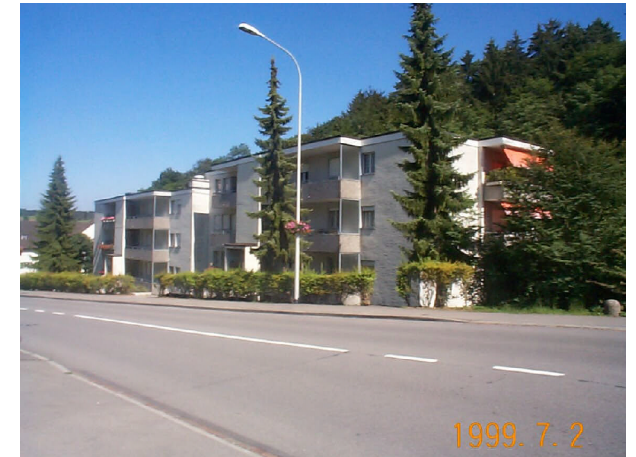
Strassenfassade vor Umbau/ Aufstockung
