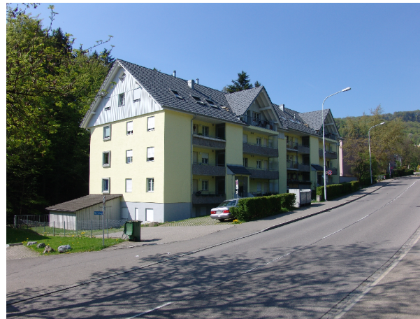
Strassenfassade nach Umbau/ Aufstockung
