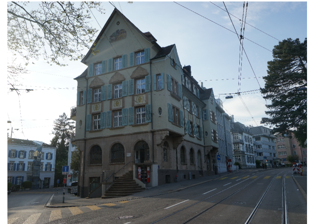
Strassenfassade nach Sanierung
