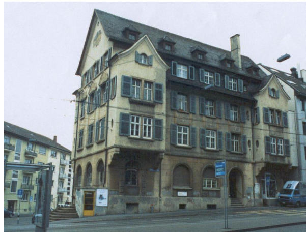
Strassenfassade vor Sanierung
