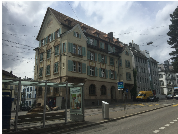
Strassenfassade nach Sanierung
