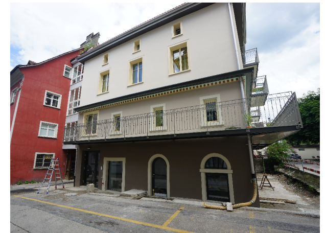
Strassenfassade nach Umbau
