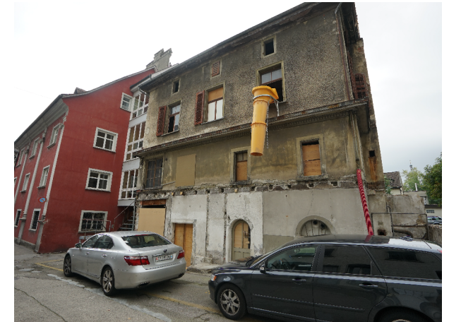
Strassenfassade vor Umbau
