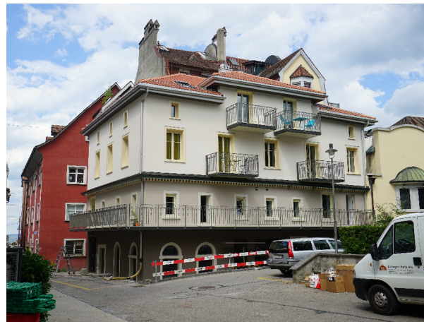
Strassenfassade nach Umbau
