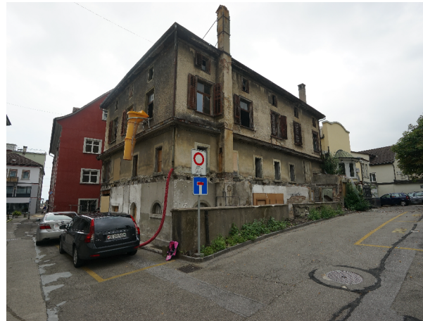
Strassenfassade vor Umbau
