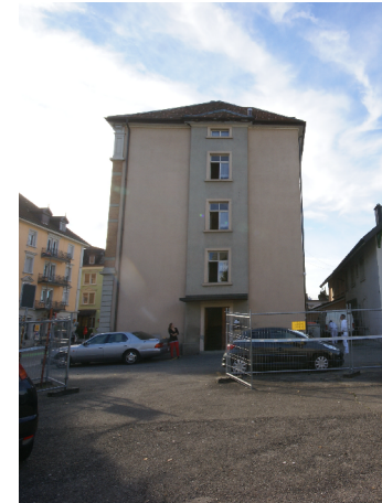
Strassenfassade vor Umbau
