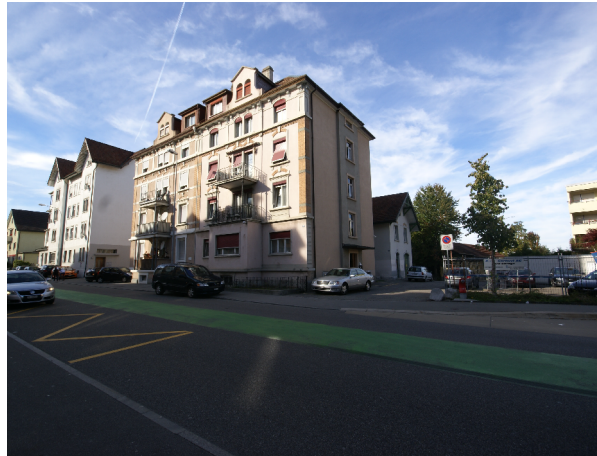
Strassenfassade vor Umbau
