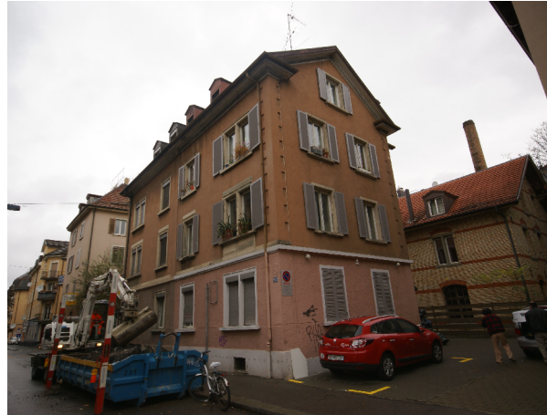
Strassenfassade vor Sanierung/ Aufstockung
