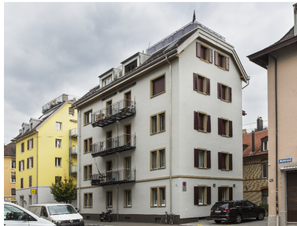
Strassenfassade nach Sanierung/ Aufstockung
