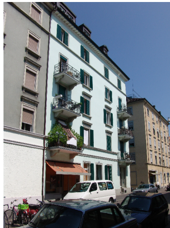
Strassenfassade vor Umbau-/ Anbau
