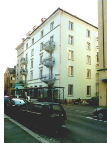
Strassenfassade vor Umbau-/ Anbau
