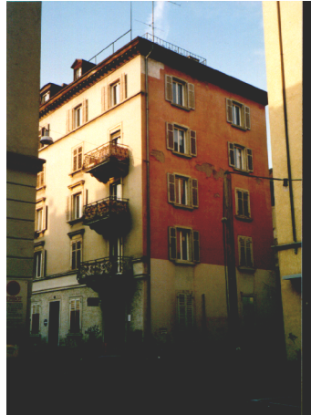
Strassenfassade vor Umbau-/ Anbau
