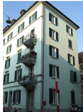
Strassenfassade vor Umbau-/ Anbau
