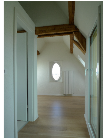
Dachgeschoss nach Umbau
