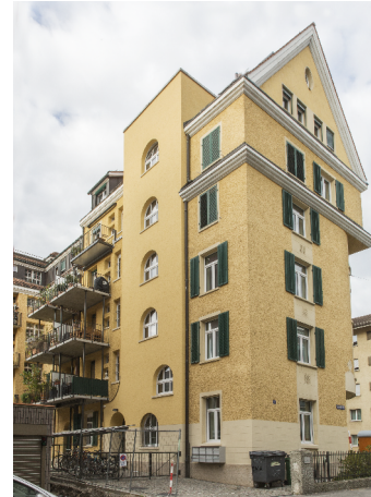
Strassenfassade nach Umbau
