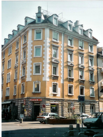
Strassenfassade vor Umbau
