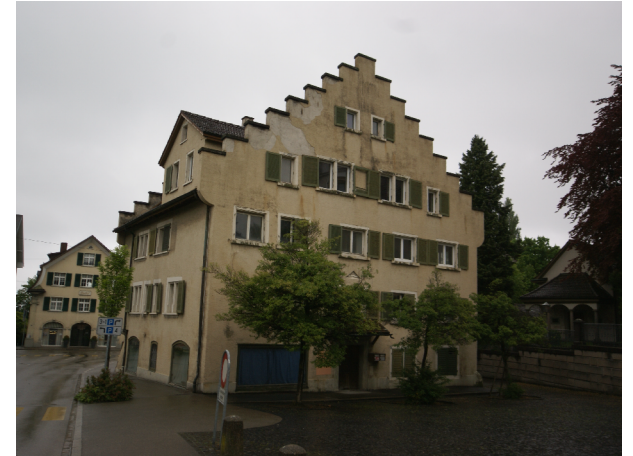
Strassenfassade vor Umbau
