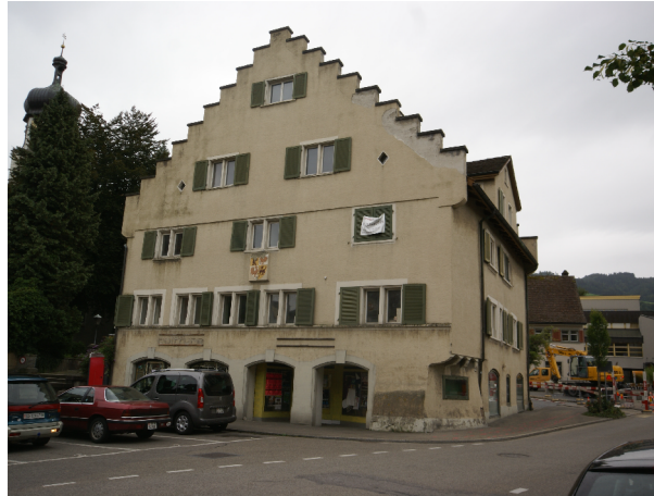
Strassenfassade vor Umbau
