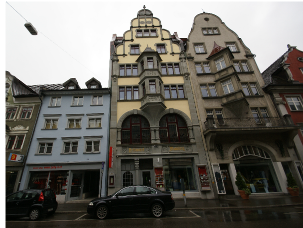
Bahnhoffassade nach Sanierung/ Aufstockung
