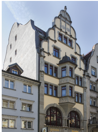
Strassenfassade nach Umbau
