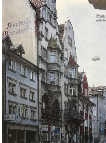
Strassenfassade vor Umbau
