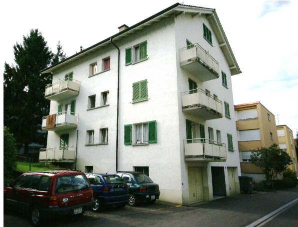
Strassenfassade vor Sanierung/ Aufstockung
