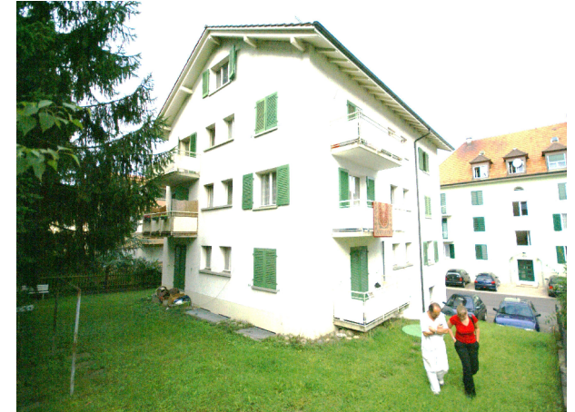
Strassenfassade vor Sanierung/ Aufstockung
