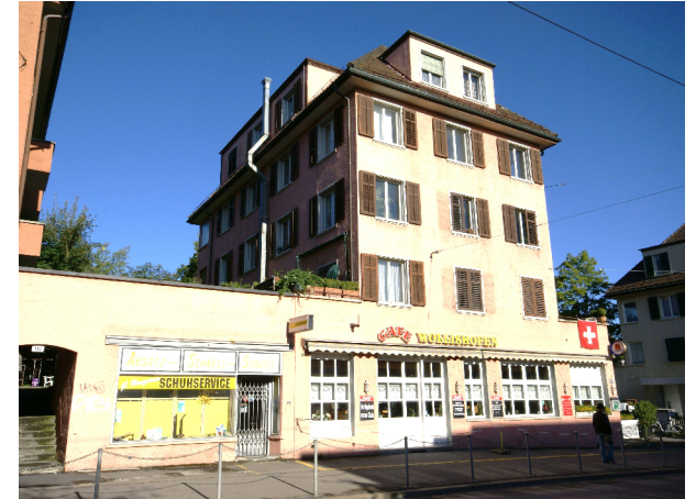
Strassenfassade vor Sanierung
