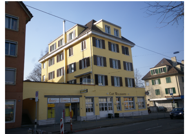
Strassenfassade nach Sanierung
