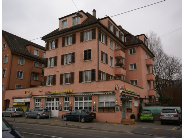
Strassenfassade vor Sanierung
