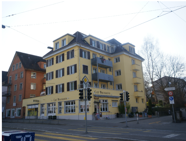
Strassenfassade nach Sanierung
