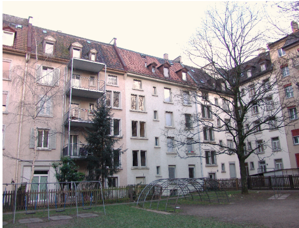
Strassenfassade vor Umbau/ Aufstockung
