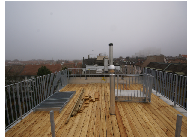
Dach nach Umbau/ Aufstockung
