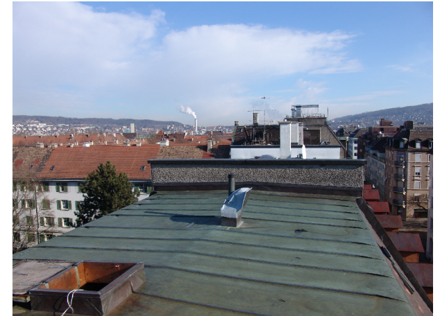
Dach vor Umbau/ Aufstockung
