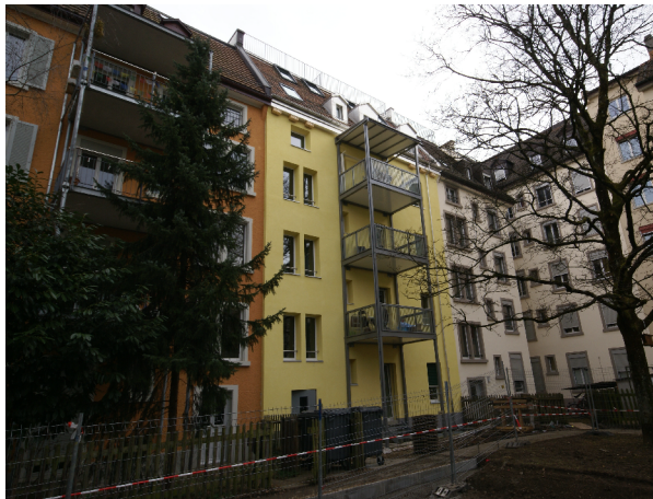
Strassenfassade nach Umbau/ Aufstockung
