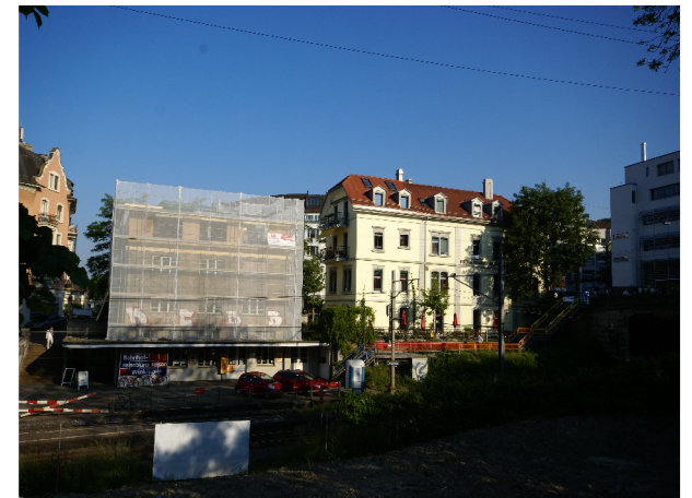
Bahnhofsfassade nach Sanierung/ Aufstockung
