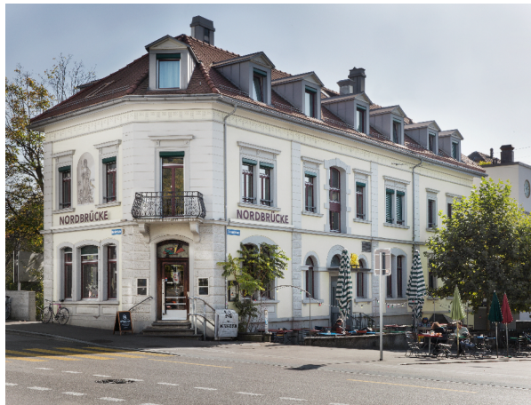
Strassenfassade nach Sanierung/ Aufstockung
