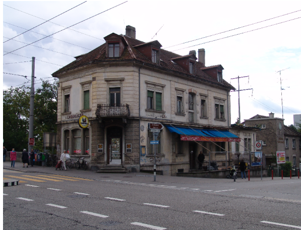
Strassenfassade vor Sanierung/ Aufstockung
