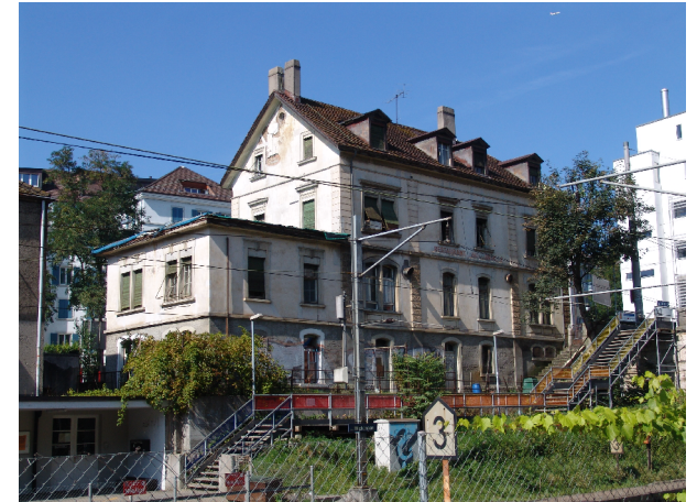
Bahnhofsfassade vor Sanierung/ Aufstockung
