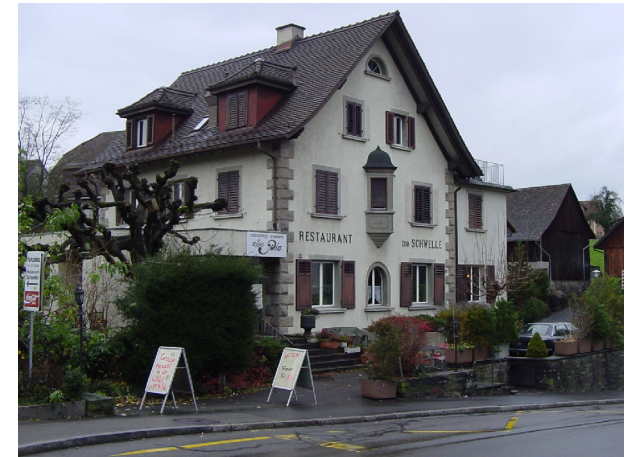
Strassenfassade vor Umbau/ Dachausbau
