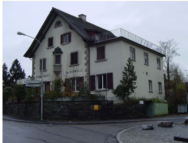
Strassenfassade vor Umbau/ Dachausbau
