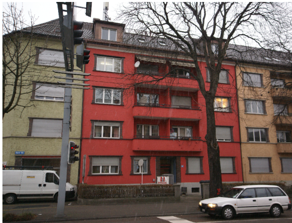
Strassenfassade nach Sanierung/ Aufstockung
