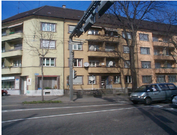
Strassenfassade vor Sanierung/ Aufstockung
