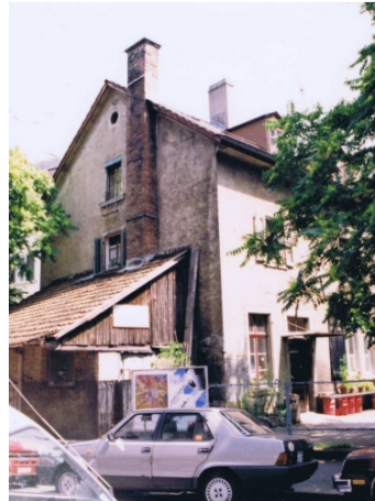
Strassenfassade vor Umbau/ Aufstockung/ Anbau
