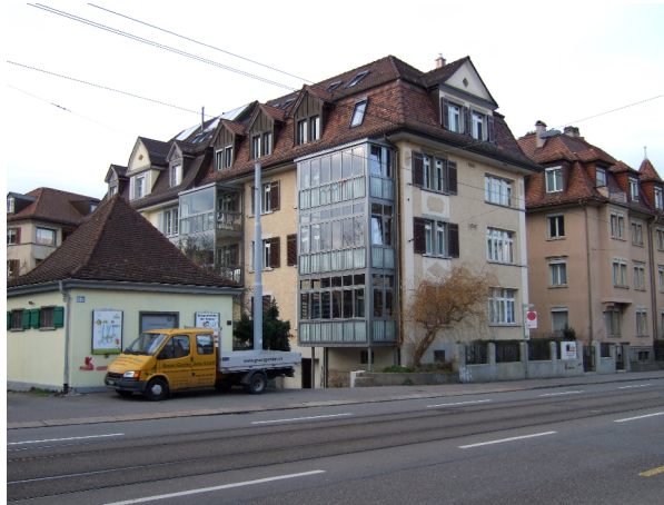
Strassenfassade nach Sanierung/ Dachausbau
