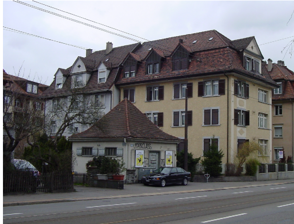
Strassenfassade vor Sanierung/ Dachausbau
