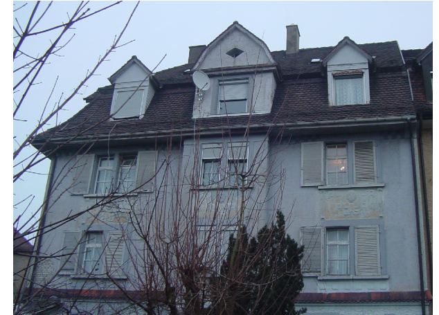
Strassenfassade vor Sanierung/ Dachausbau
