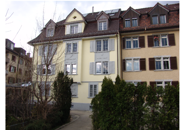
Strassenfassade nach Sanierung/ Dachausbau
