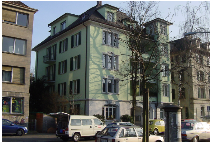
Strassenfassade nach Sanierung
