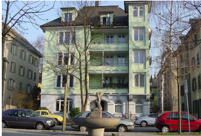
Strassenfassade nach Sanierung
