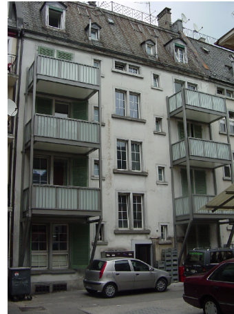
Strassenfassade vor Sanierung
