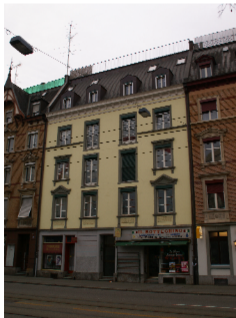
Strassenfassade nach Sanierung
