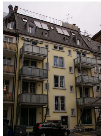
Strassenfassade nach Sanierung
