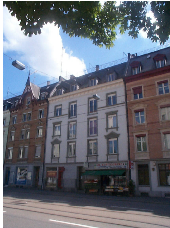
Strassenfassade vor Sanierung
